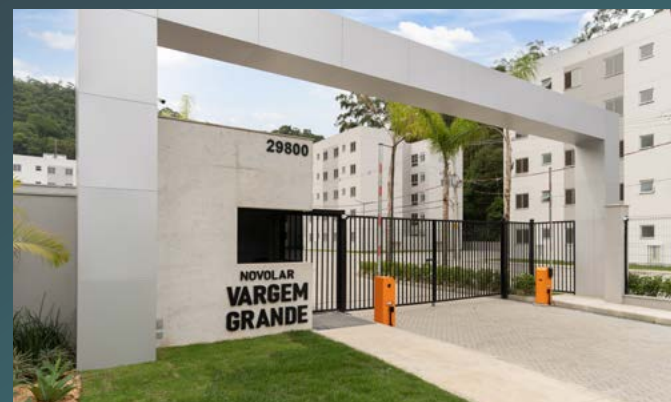
Novolar Vargem Grande - Rio de Janeiro/RJ
